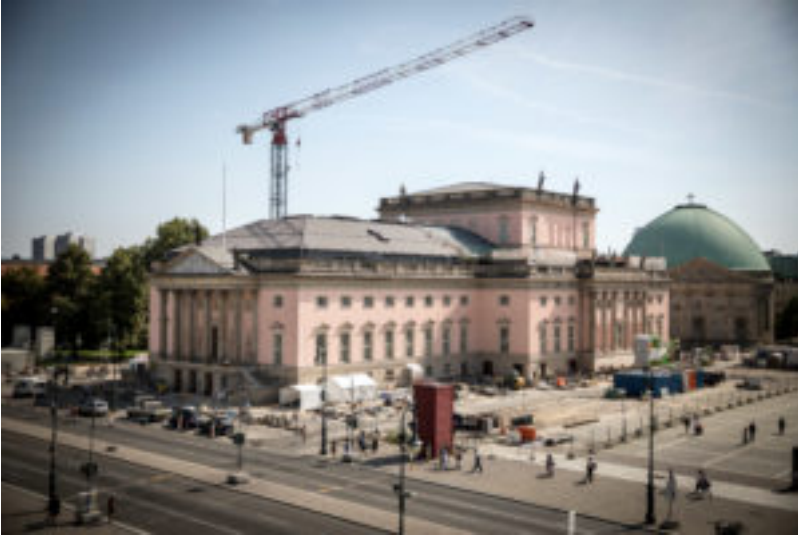
Esterno durante i restauri © Gordon Welters
